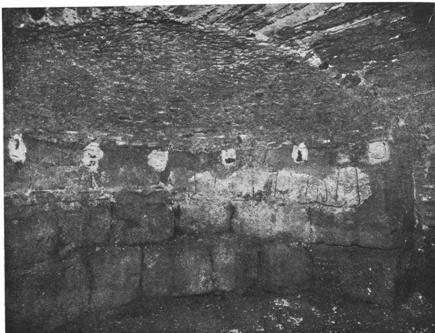
Fig. 51 — S. ANGELO IN PESCHERIA. — Abside sinistra con resti di pitture.
